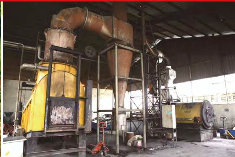
再資源化が進み、週1回しか使われなくなった焼却炉
